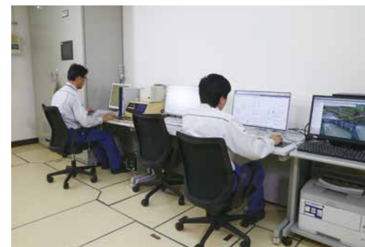
受入から放流までの各機器の運転状況について監視しています。
